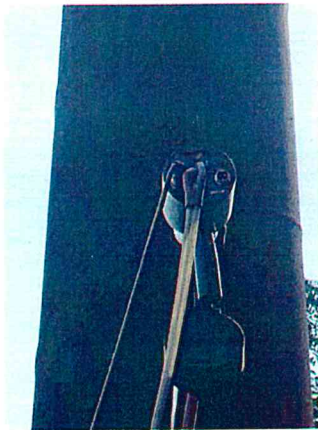
图 1: 锅炉废气排放口监测点
